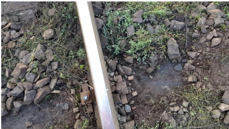
Traversa nr. +1 – primul șurub vertical lovit capătul traversei corespunzător șinei din partea dreaptă a sensului de mers (firul interior al curbei)
