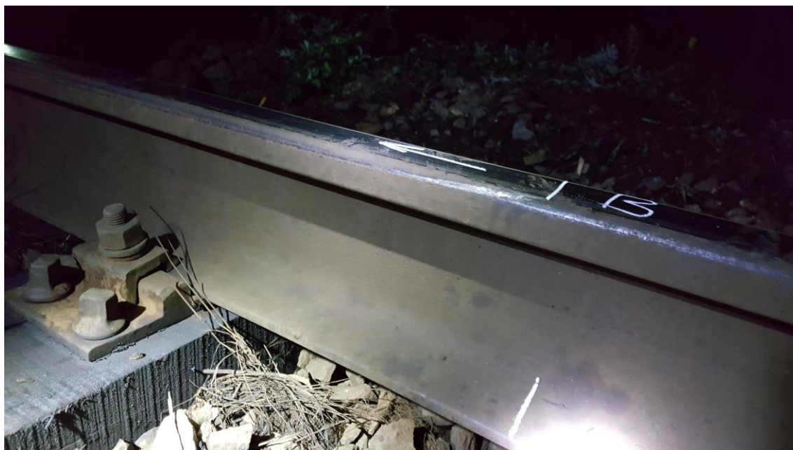
Șina de pe firul interior al curbei - pct.B - prima urmă în sensul de mers al trenului pe fața laterală activă a ciupercii șinei firului interior al curbei
