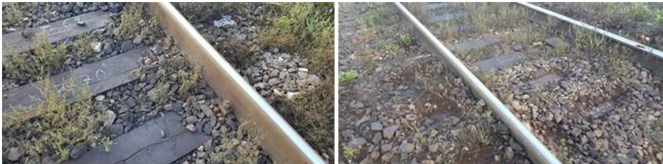
Zone cu piatră spartă și vegetație care împiedică vizualizarea stării tehnice a traverselor în zona de fixare a plăcilor metalice
