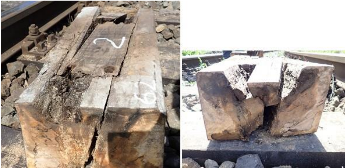
chitucul 2 - inimă roșie, crăpături pe fața superioară și crăpătură în adâncime pe lungimea chitucului, lemn putrezit pe fața superioară și în interior
