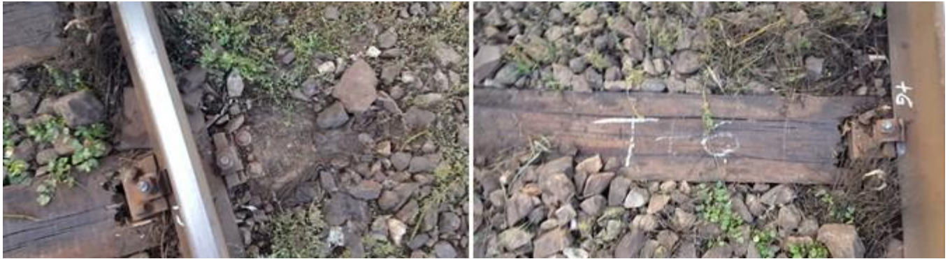
Traversele nr +5 și nr. +6 capătul corespunzător șinei din partea dreaptă a sensului de mers (firul interior al curbei)
