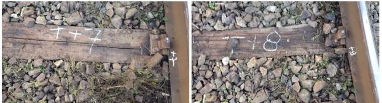
Traversele nr +7 și nr. +8 capătul corespunzător șinei din partea dreaptă a sensului de mers (firul interior al curbei)
