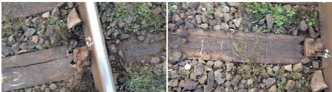
Traversele nr +3 și nr. +4 capătul corespunzător șinei din partea dreaptă a sensului de mers (firul interior al curbei)
