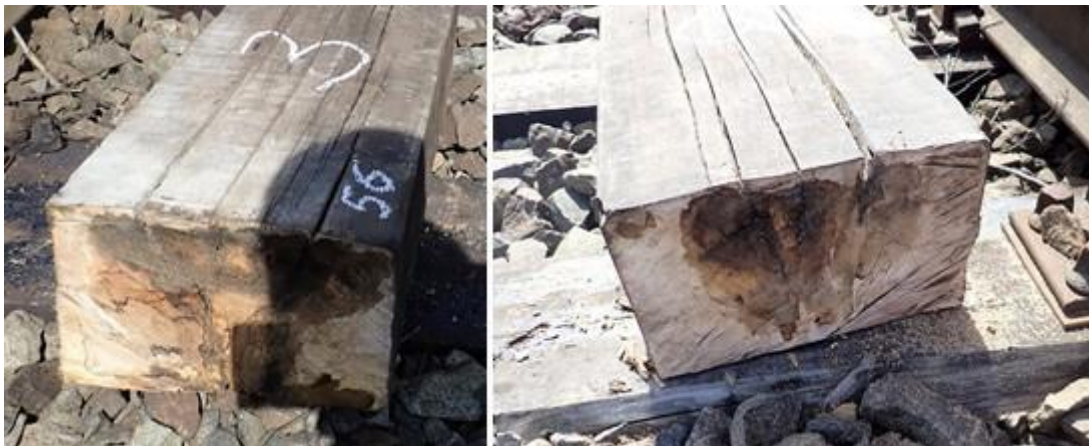
chitucul 3 - inimă roșie, crăpături dinspre fața superioară spre interior, formare secțiuni de rupere
