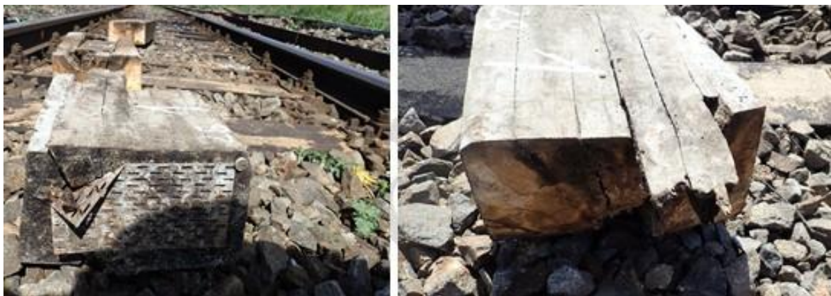
chitul 1 – inimă roșie, crăpături pe fața superioară și în adâncime, putrezire la partea inferioară
